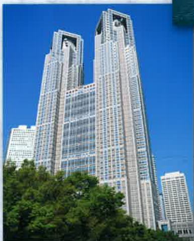
高層ビルのシーリング 複層ガラスのシール材塗布
